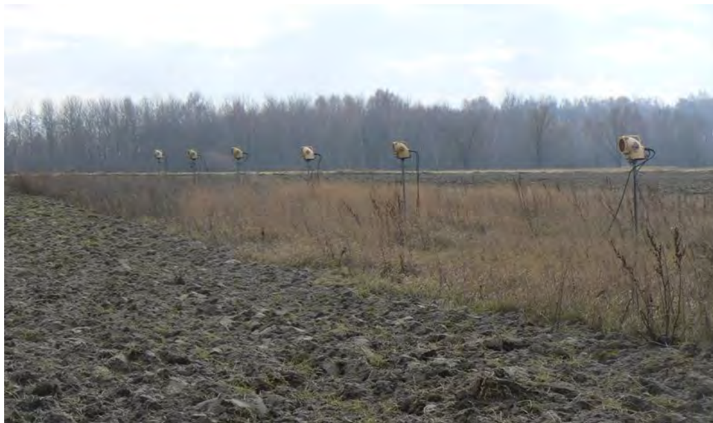
Фот. 23. Строение элементов и окружение светосигнальной системы ЛУЧ-2МУ, установленной на военном аэродроме
