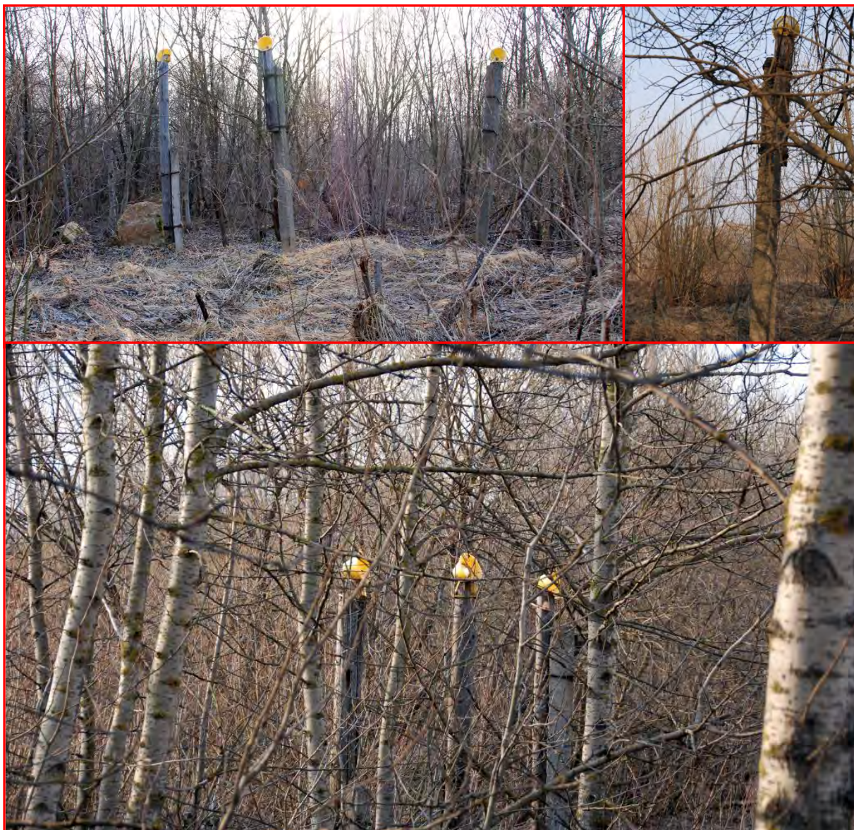
Фот. 20. Навигационные огни, закрытые деревьями и кустарниками
