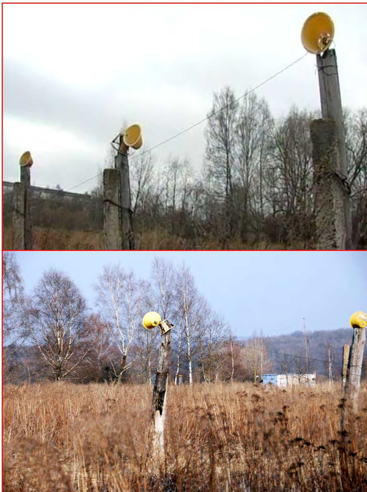
Фот. 22. Техническое состояние огней подхода
