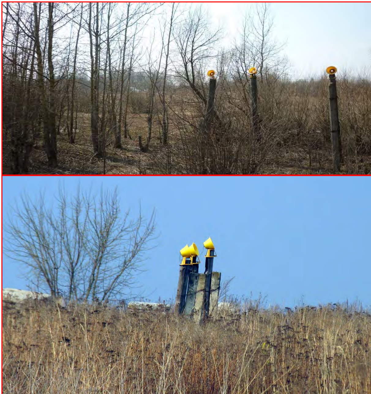
Фот. 21. Установка огней подхода
