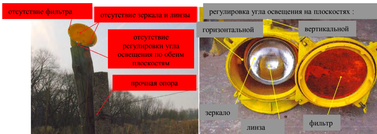
Фот. 23. Строение элементов и окружение светосигнальной системы ЛУЧ-2МУ, установленной на военном аэродроме
